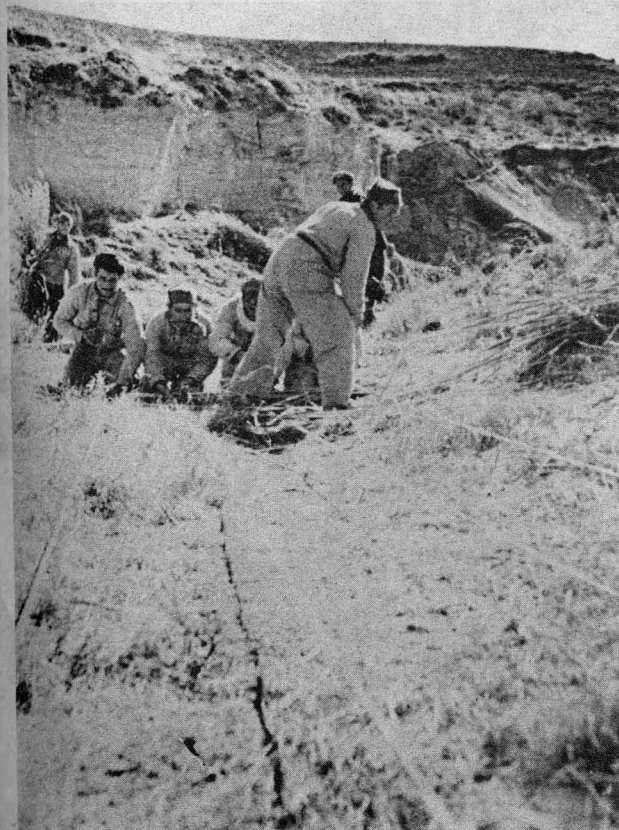
Soldados del cuerpo de zapadores trazando las líneas para la construcción de trincheras en el frente de Madrid. Estas trincheras forman parte de las nuevas líneas de resistencia preparadas por el general Miaja en previsión de un ataque en gran escala sobre el sector del Centro. (Foto SEI).
